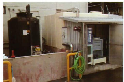
タンク容量2t次亜塩素酸ナトリウムタンク、タンク容量10tカンファ水タンク
